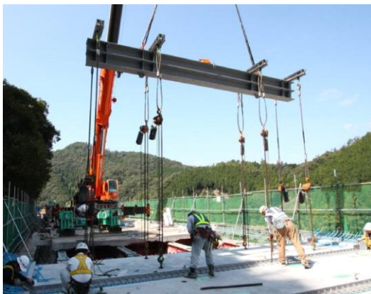
写真-11 PcaPC 床版の設置状況
