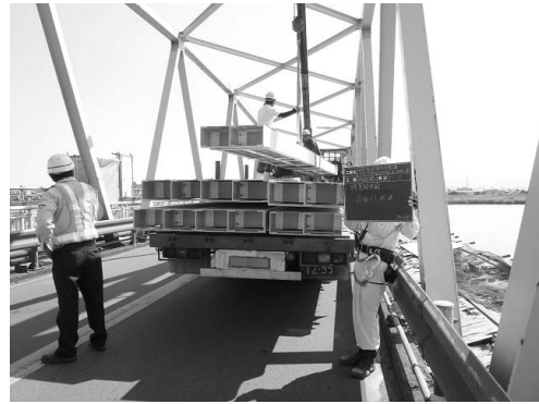
図-17 検査路の荷下ろし（ユニック車）
