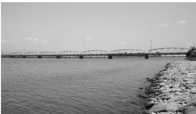
図-15 新保橋の全景
