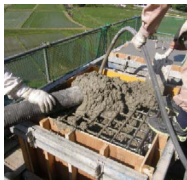
写真-1 模擬打設の状況
