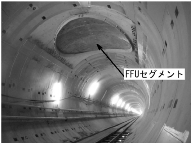
写真-2 上向きシールド発進部
