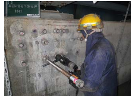
図-9 Rアンカー抜き取り状況
