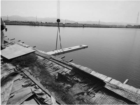
図-18 桁下の足場への取込み
