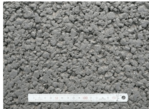
写真-1 機能性SMA施工直後の路面
