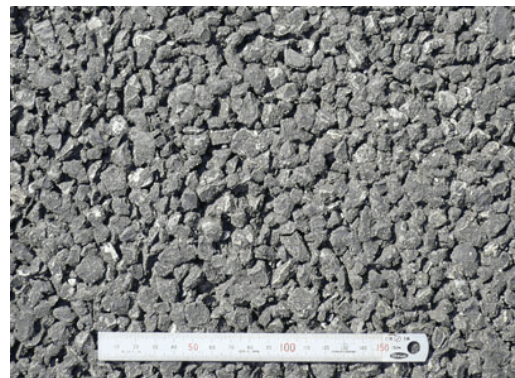
写真-2 排水性舗装の路面
