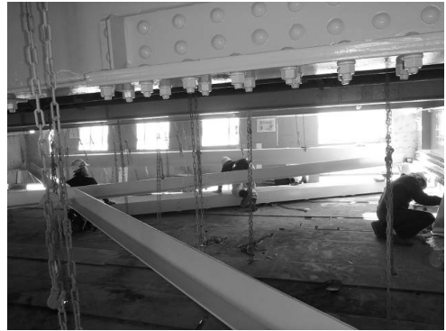
図-19 桁下の足場上での移動
