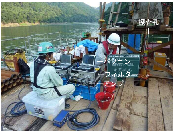
写真-2 調査状況 (計測システム)
