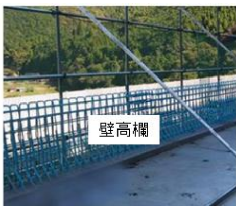
写真-8 エポキシ樹脂鉄筋 (壁高欄部)
