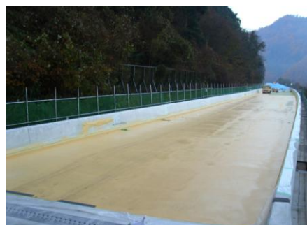
写真-10 ウレタン床版防水工
