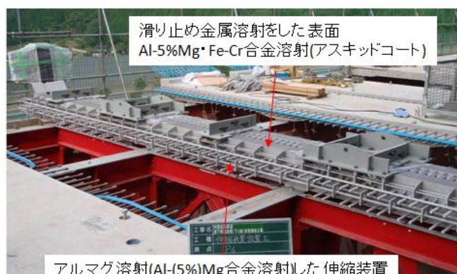
写真-9 アルマグ溶射
