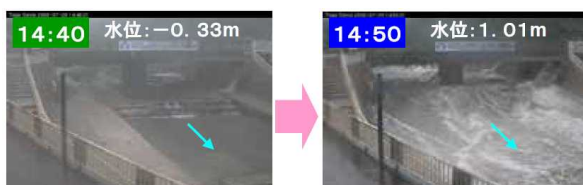
図-2 都賀川甲橋 水位上昇状況（神戸市モニタリング画像）
