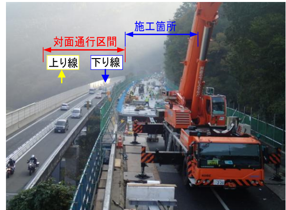
写真-12 対面通行規制下での施工状況
