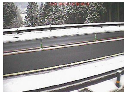
図-11 杉俣トンネル大野側出口付近の路面状況
