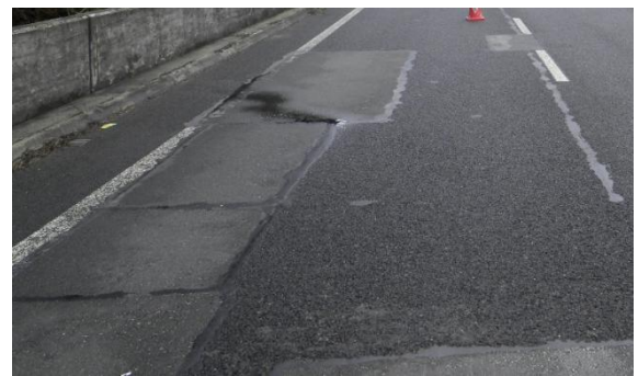
写真-1 アスファルト舗装の部分補修
