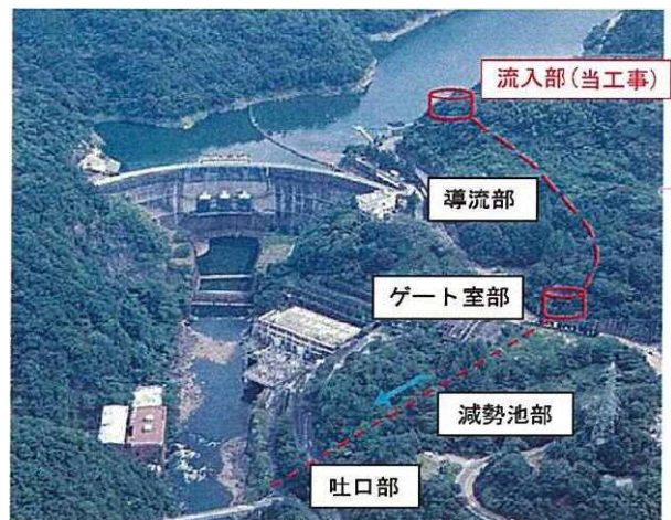
写真-1 天ヶ瀬ダム放流設備再開発工事
