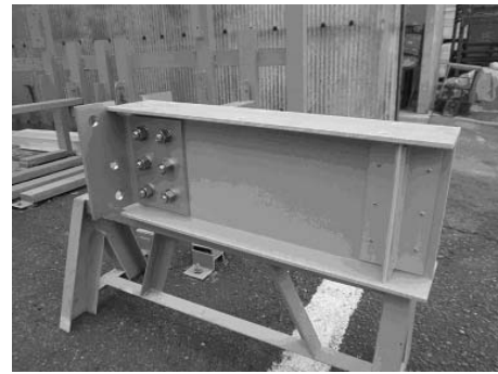
図-24 ブラケット製作完了状況
