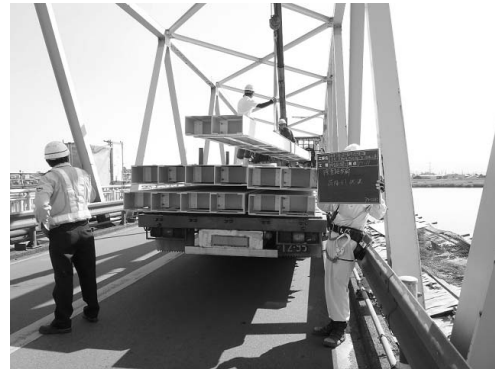
図-17 検査路の荷下ろし（ユニック車）
