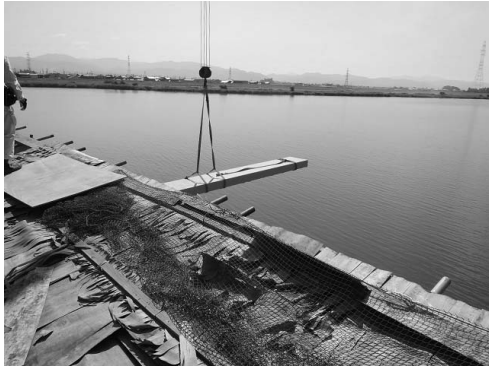
図-18 桁下の足場への取込み
