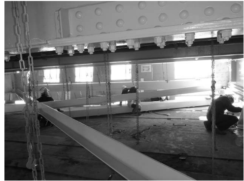
図-19 桁下の足場上での移動
