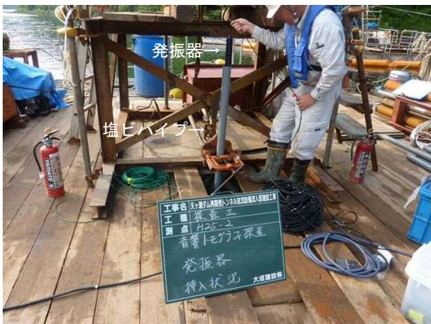
写真-3 探査状況 (発振孔)
