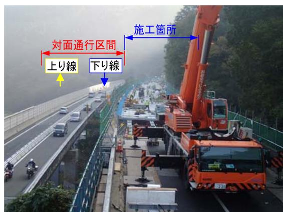
写真-12 対面通行規制下での施工状況
