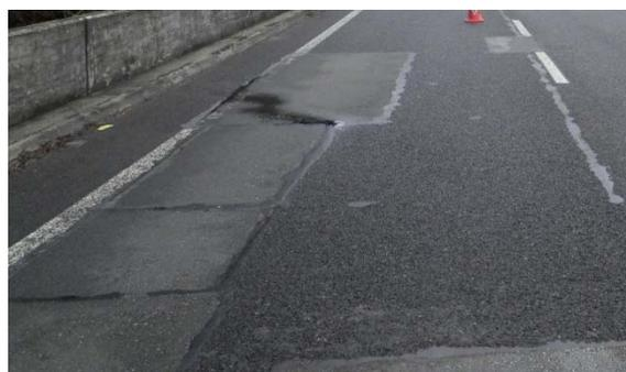
写真-1 アスファルト舗装の部分補修
