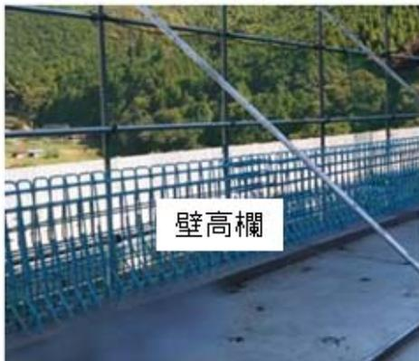
写真-8 エポキシ樹脂鉄筋 (壁高欄部)
