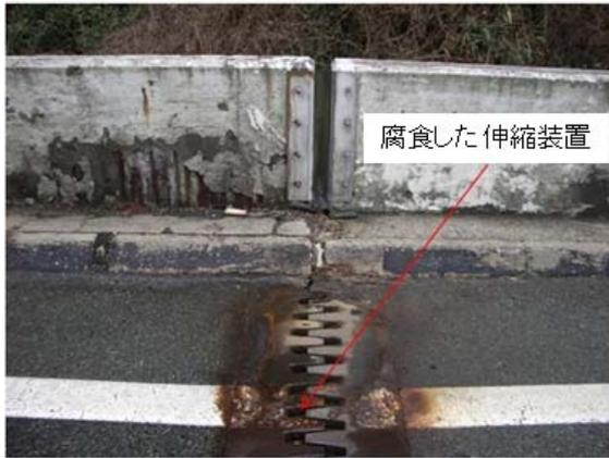
写真-4 壁高欄・伸縮装置の劣化状況
