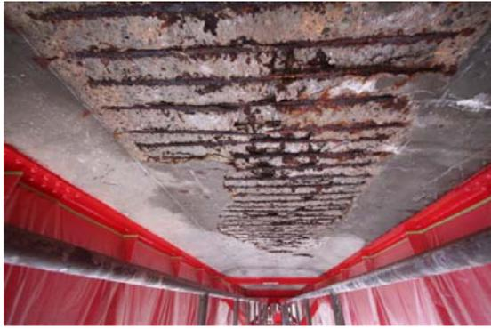
写真-3 床版下面の劣化 (かぶり剥落)
