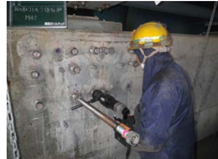
図-9 Rアンカー抜き取り状況
