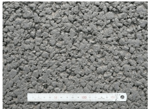
写真-1 機能性SMA施工直後の路面
