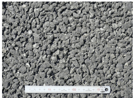
写真-2 排水性舗装の路面
