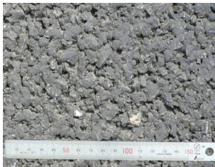
写真-2 葛岡工区
