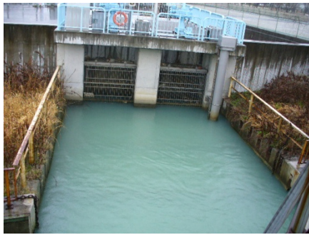
写真-1 水路からの白濁水
