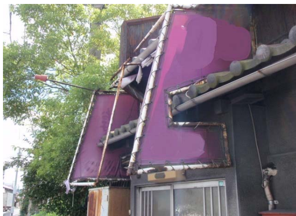
写真-2 腐蝕劣化を伴う日よけ
