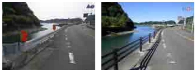
写真-4 景観に配慮した防護柵設置例(すさみ町)
