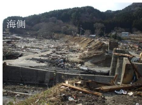
写真-2 鉄道盛土の被災写真(2011年3月撮影)
