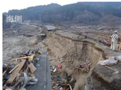
写真-1 道路盛土の被災写真(2011年3月撮影)
