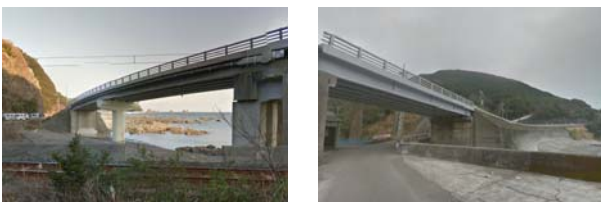
写真-2 JRや海岸から見た国道42号
