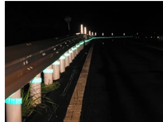
写真-3 防護柵反射テープ
