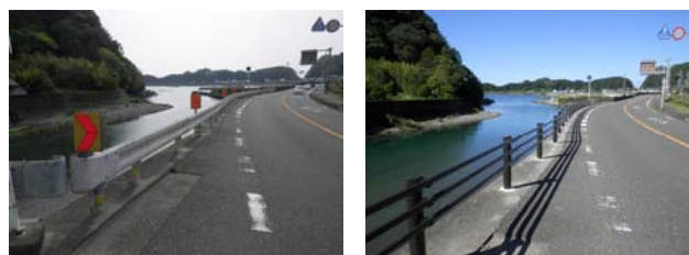
写真-4 景観に配慮した防護柵設置例(すさみ町)
