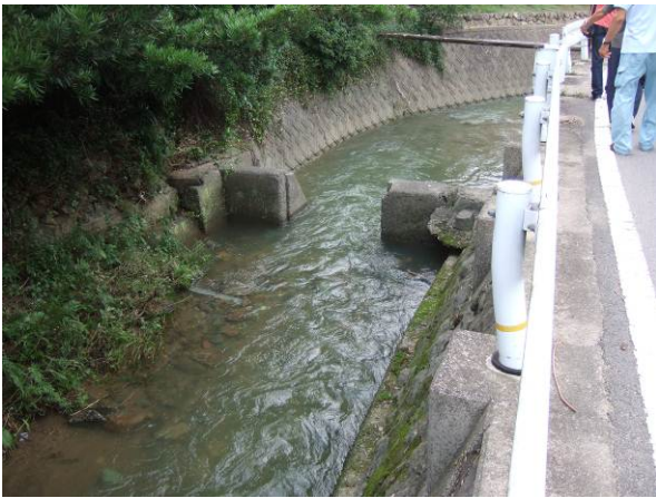
写真-2 当該地区で撤去した取水堰（撤去前の写真）
