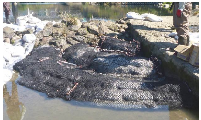
完成した簡易魚道
