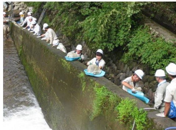
ナルミ井堰魚道の簡易改良作業のようす （魚道最上流部への土のうの運搬）
