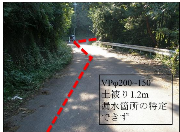
写真-1 現場状況
