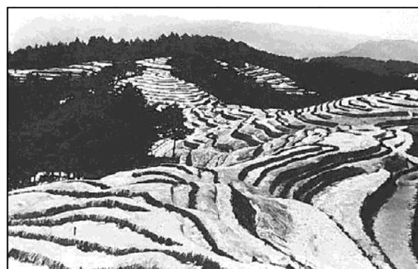
写真-1 禿 とく 禿 しゃち 地に対する山腹工の施工状況（昭和25年）
