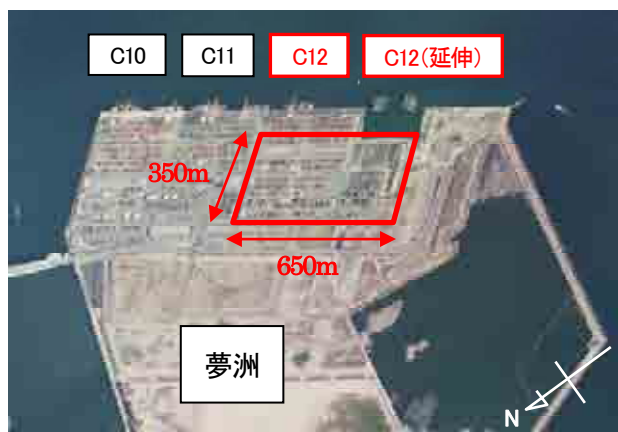
写真-1 北港南地区 荷さばき地 全景
