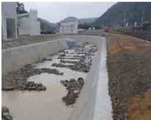
図-21 付替河川河岸部分(右側が南海電鉄)
