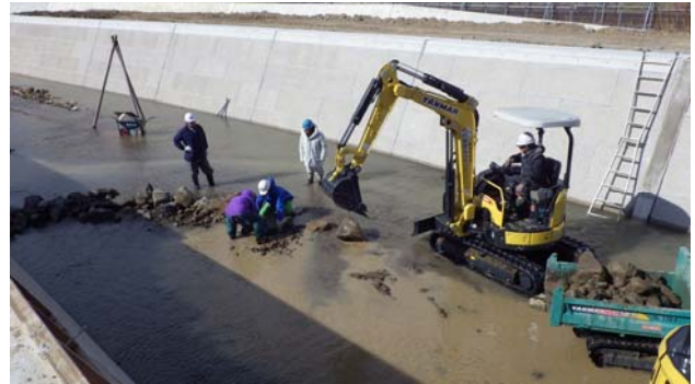
図-17 モデル施工実施状況
