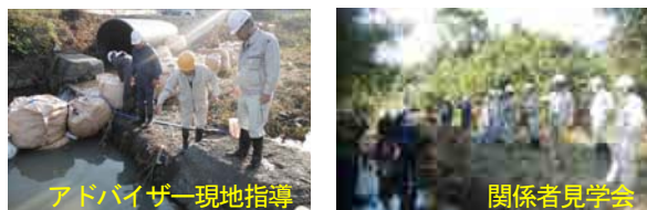
図-13 モデル施工実施状況
