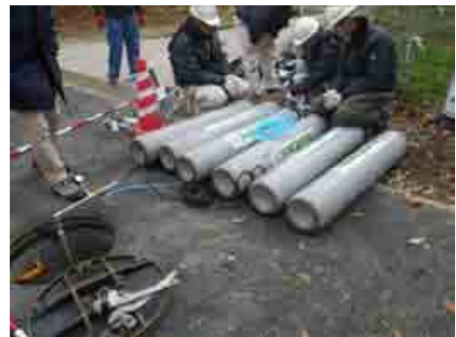
写真-4 ガス注入状況
