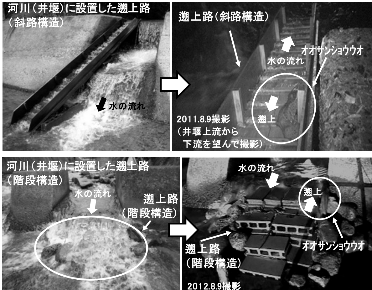
図-11 河川に試験的に設置した遡上路で確認された利用状況
