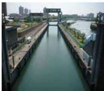
船が入る前の閘室
