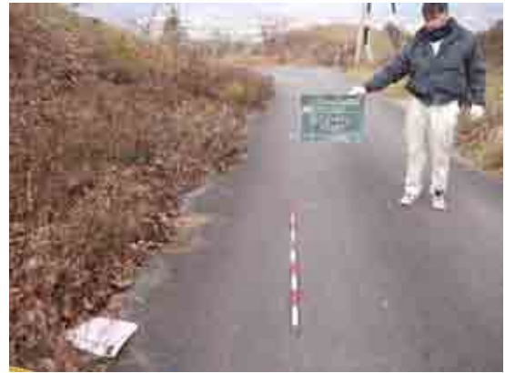
写真-3 漏水箇所特定地点
