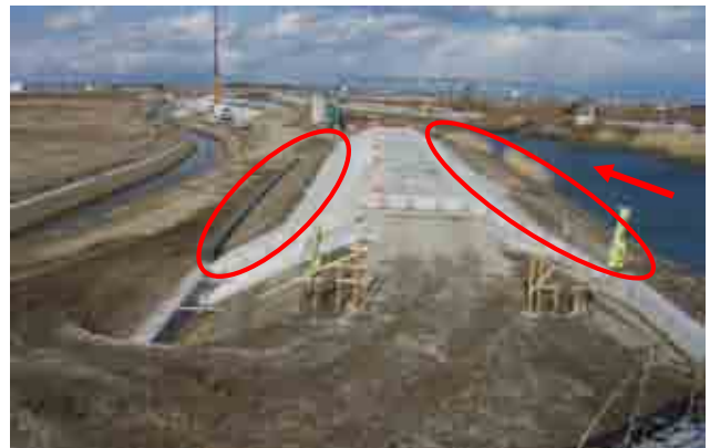
図-10 中貞山運河における堤防表面の覆土式【試行中】
