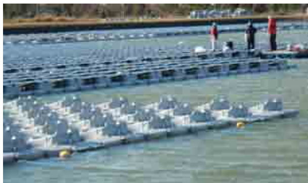
写真-1 東出池施工状況
