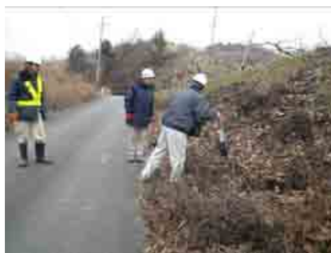
写真-8 漏水特定箇所②
