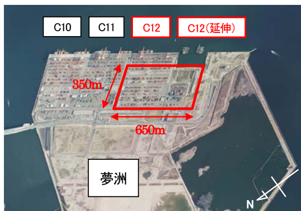
写真-1 北港南地区 荷さばき地 全景
