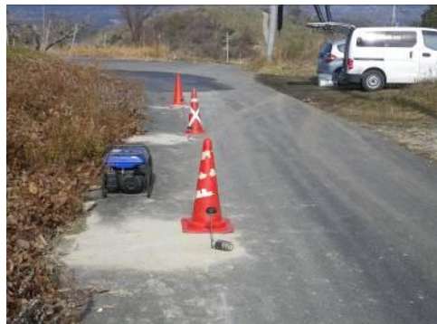
写真-10 センサー設置②
