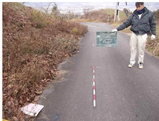
写真-3 漏水箇所特定地点
