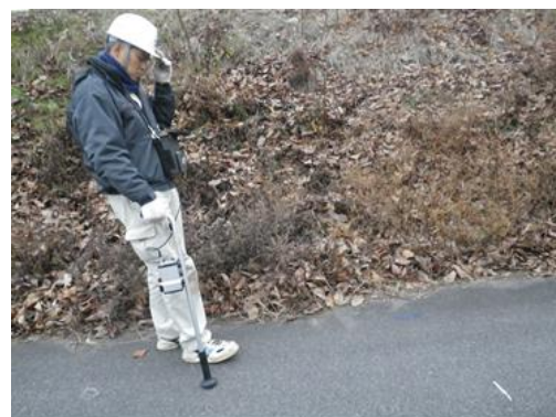
写真-5 ガス検知状況①
