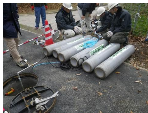
写真-4 ガス注入状況
