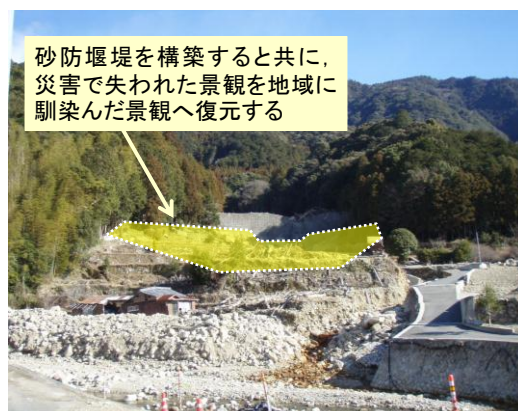
写真-5 地域環境対策のコンセプト（内の川）
