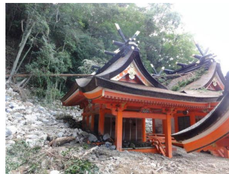
写真-1 熊野那智大社の被害状況 2)
