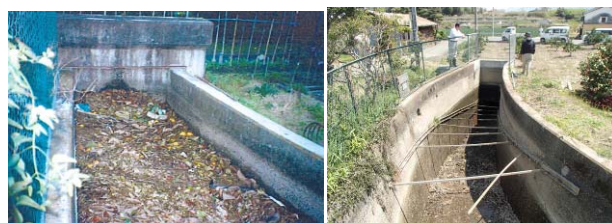
写真-1 出口トランジション部
