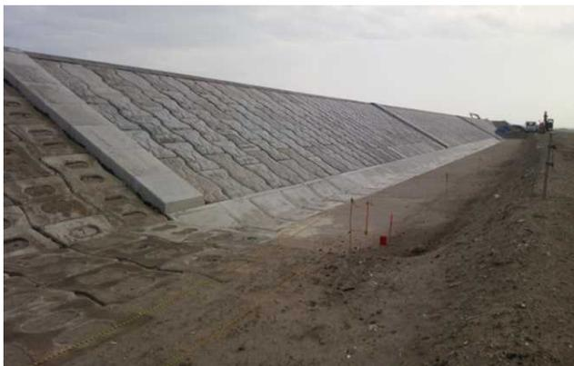
図-8 景観に配慮した海岸堤防の護岸
