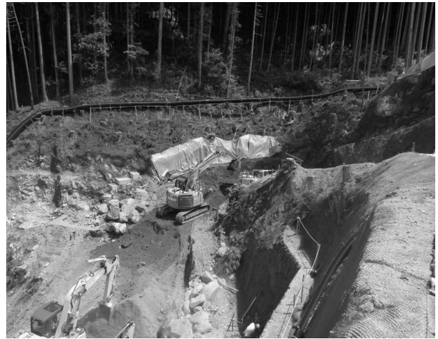
写真-1 付替県道青山美線上流部整備工事の様子
