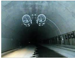
トンネル換気設備
