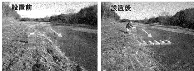
写真-2 試験施工の実施(水制工)
