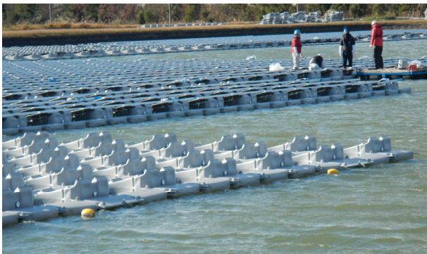
写真-1 東出池施工状況
