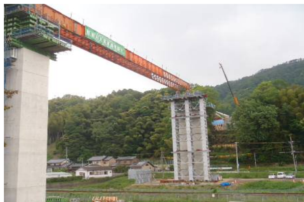
図-11-② 手延べ桁先端 仮受けベント到達状況
