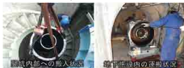
写真5 水車・発電機の搬入状況
