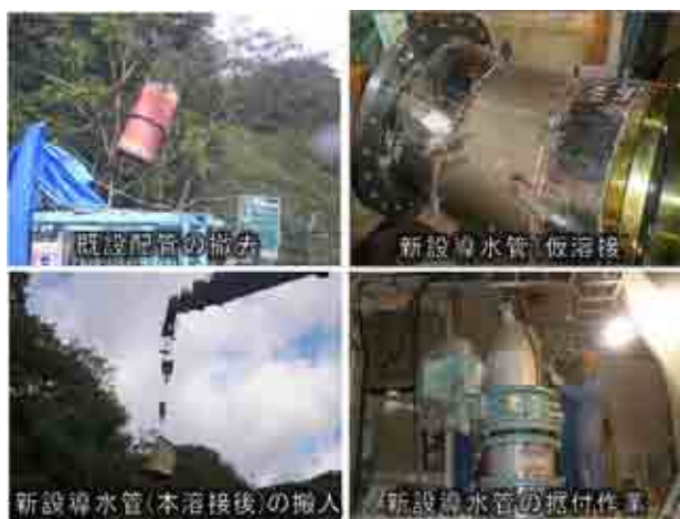
写真-6 現地合わせによる導水管設置状況
