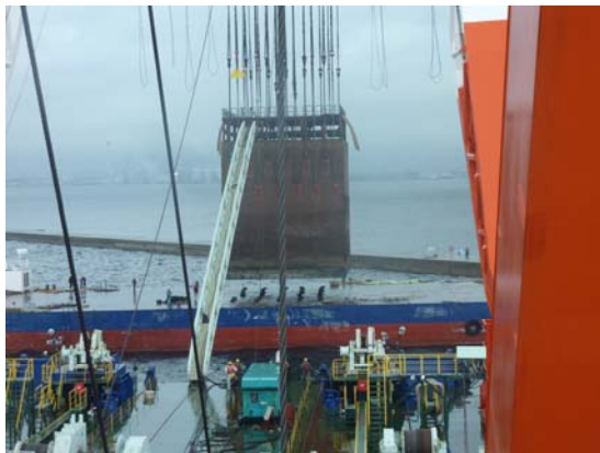
写真-4 ケーソン吊り上げ及び台船積込
