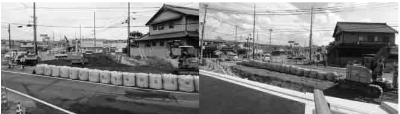
図4, 町道嵩上工事施工状況
