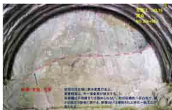
図-12 ヒ素の高濃度溶出値を得た代表的切羽写真
