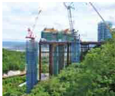
写真-4 雄ノ山高架橋（移行部）
