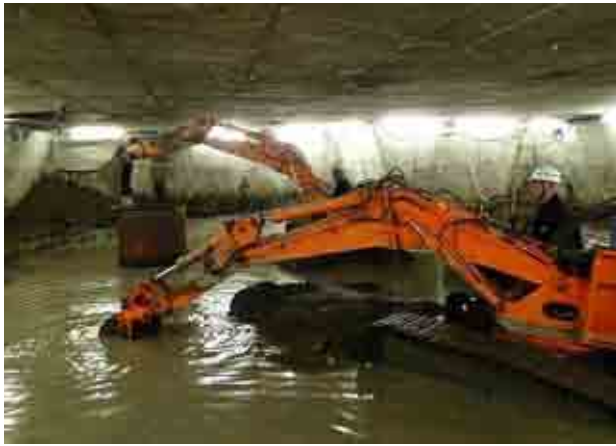
写真-2 作業室内水張り掘削の状況
