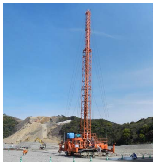
写真-2 バーチカルドレーン打設機（超大型機）
