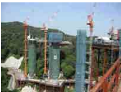
写真-3 和歌山 JCT（近景）
