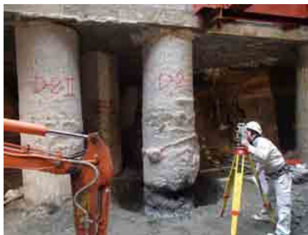
写真 2-4-2：掘削工事後の目視確認
