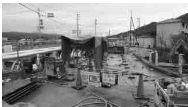
図5、ワイヤーソー切断状況
