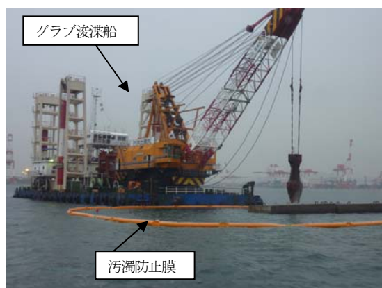
写真-6 グラブ浚渫船によるケーソン現地破碎の様子
