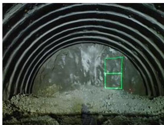
図-4 レーザー照射切羽断面写真
