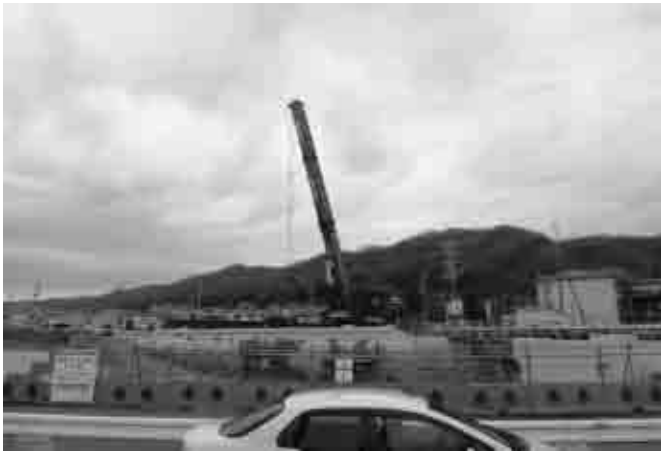
写真1, 550t オールテレーンクレーン
