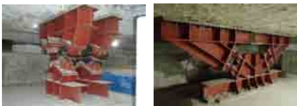
写真 4-1-1 : 仮設ブレース V3000(左)と V7000(右)
