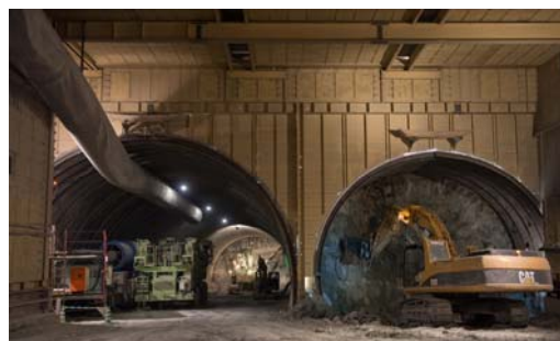
写真-2 トンネル施工状況
