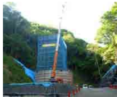
写真-6 岡野第二橋
