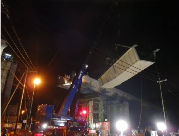
図-13 国道176号一括架設状況
