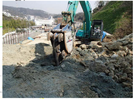
写真-3 エキセントリックリッパによる施工状況
