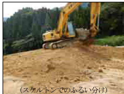
写真-2 盛土材の品質管理
