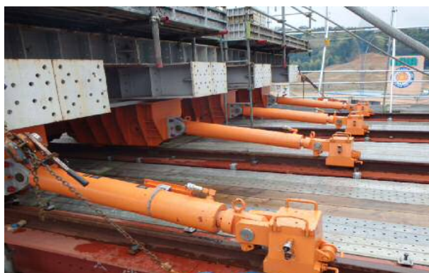
図-9 交互推進ジャッキ
