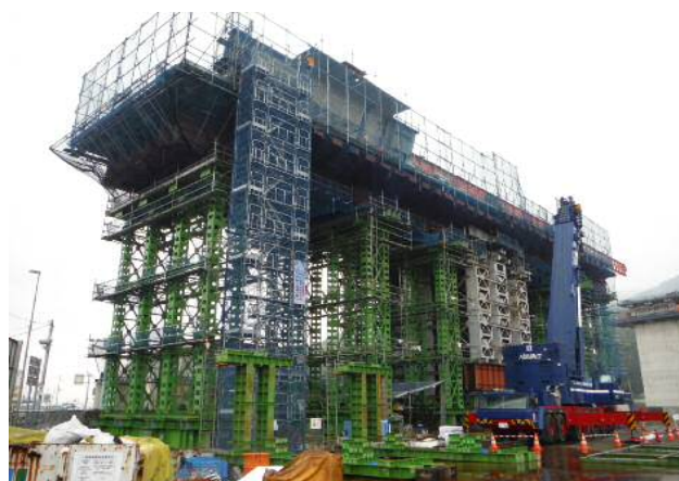
図-8-① 送り出しヤード
