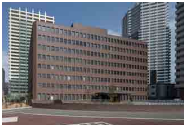
写真1：神戸地方合同庁舎 南側外観
