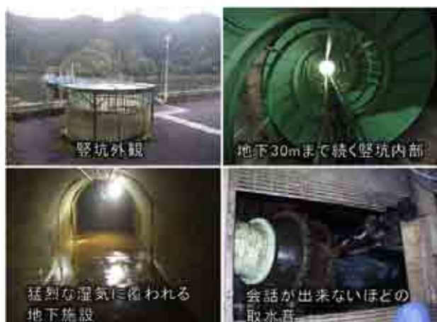
写真2 施設状況（工事前）
