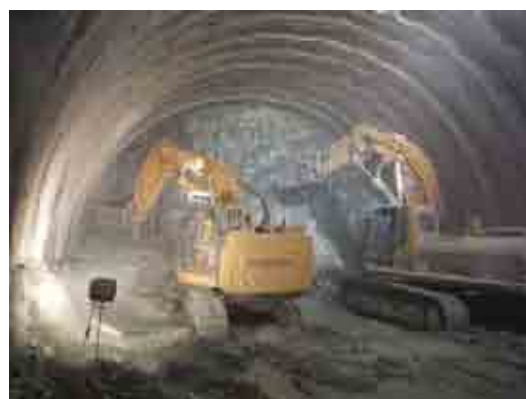
写真-5 掘削状況（下り線DI区間）
