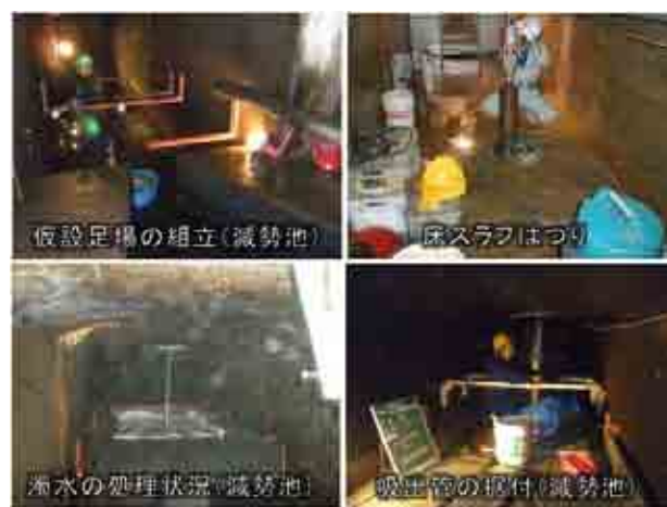
写真-8 取水停止中の作業
