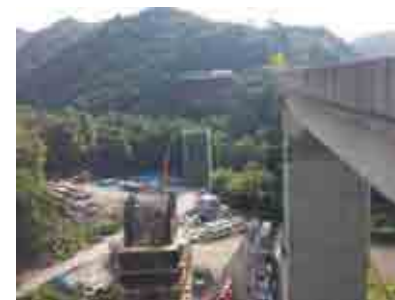
写真-7 北別所高架橋
