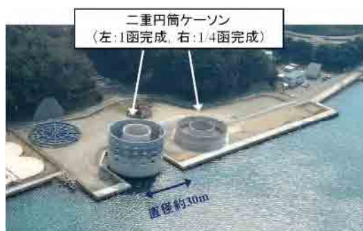
図-2 柴山港ケーソン製作ヤード
