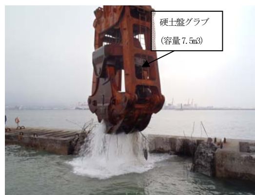
写真-8 硬土盤グラブによる撤去状況
