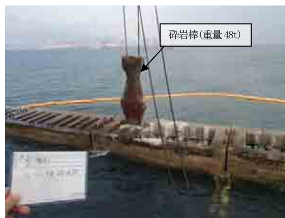
写真-7 砕岩棒による破碎状況
