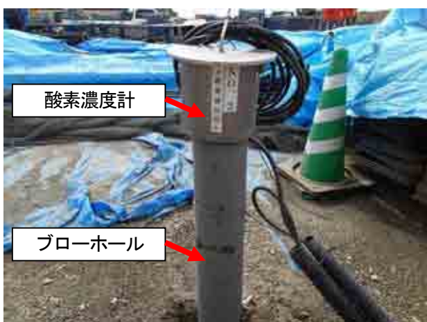
写真-4 ブローホールの設置状況
