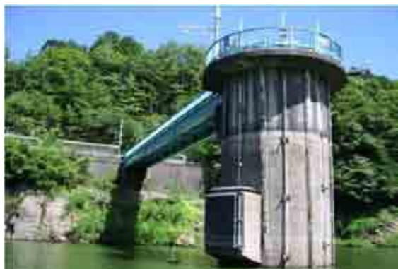
写真-1 初瀬取水施設（取水塔）
