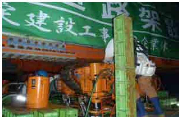
図-10 駆動式エンドレスローラー
