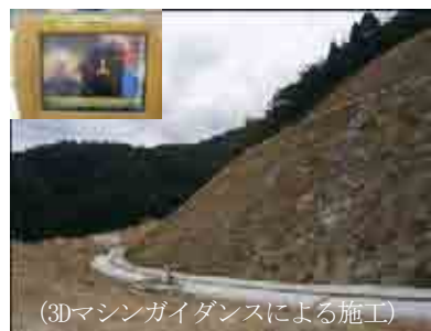
写真-1 曲線部の切土形状
