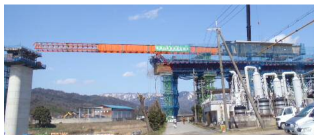
図-8-② P8橋脚到達直前の状況
