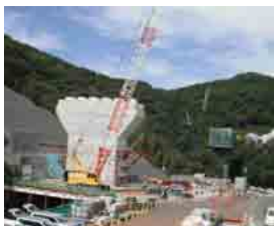
写真-1 雄ノ山高架橋（下り線・分合流部）
