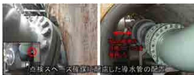
写真-7 極限まで構造物に寄せた導水管
