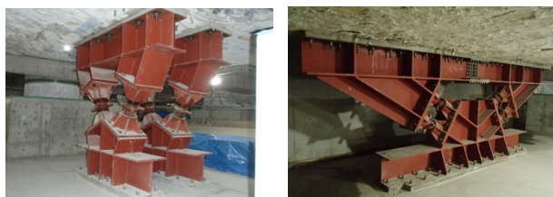
写真 4-1-1：仮設ブレース V3000(左)と V7000(右)
