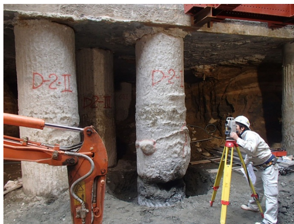
写真 2-4-2：掘削工事後の目視確認
