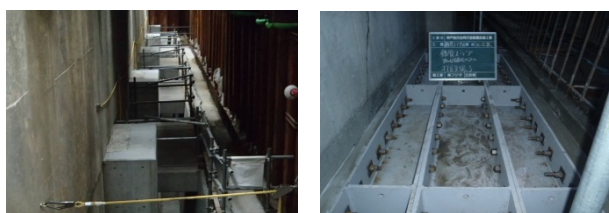
写真 4-1-2：仮設スラブ (左)と鉄骨スラブ(右)
