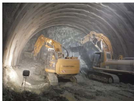
写真-5 掘削状況 (下り線 DI 区間)
