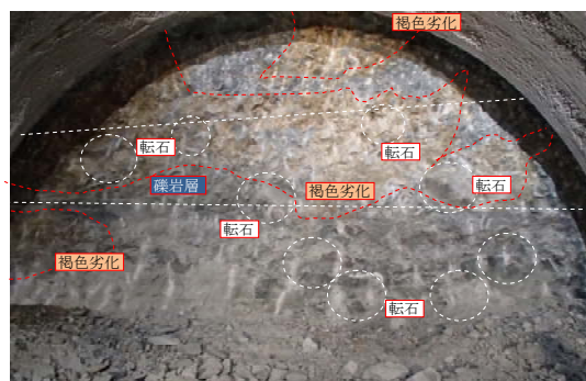
写真-3 トンネル切羽状況 (沢部通過時)
