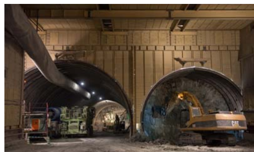
写真-2 トンネル施工状況
