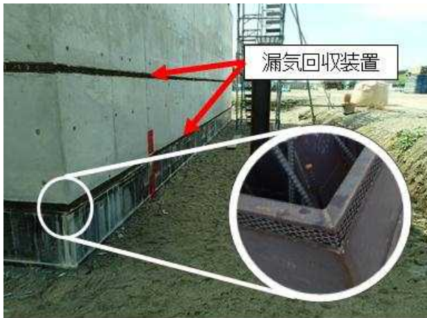
写真-3 漏気回収装置の設置状況
