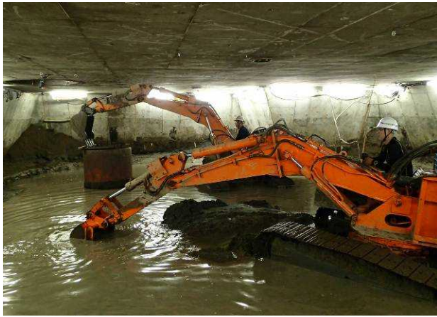
写真-2 作業室内水張り掘削の状況
