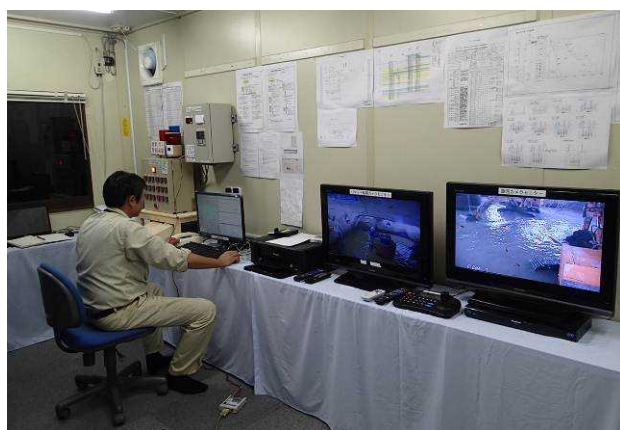
写真-1 中央監視室の状況
