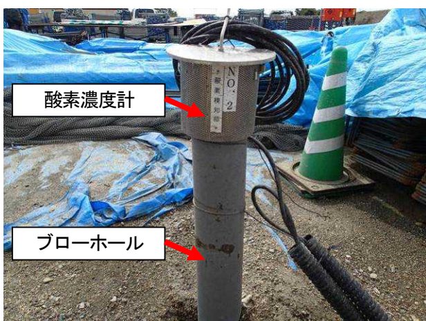
写真-4 ブローホールの設置状況
