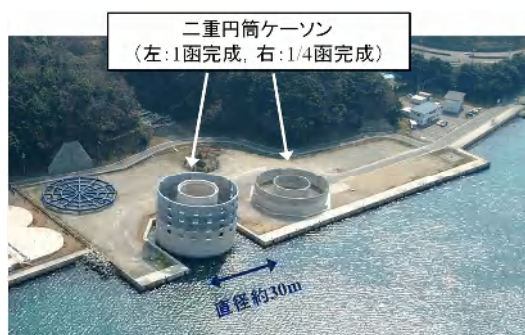
図-2 柴山港ケーソン製作ヤード
