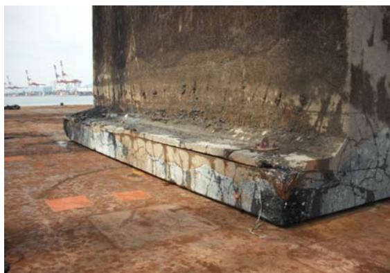
写真-5 ケーソン底板部のクラック状況
