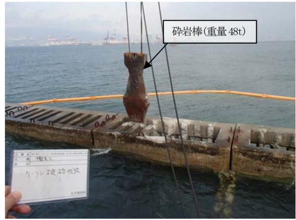
写真-7 砕岩棒による破砕状況
