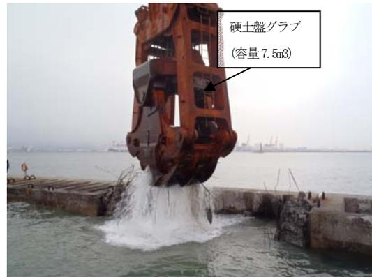
写真-8 硬土盤グラブによる撤去状況
