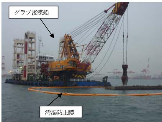
写真-6 グラブ浚渫船によるケーソン現地破砕の様子
