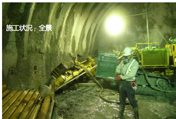
写真-1 ボーリング状況
