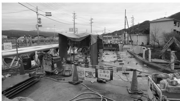
図5、ワイヤーソー切断状況
