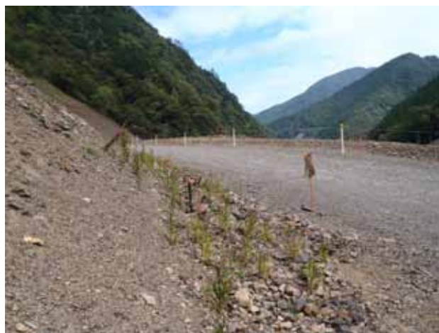
図－4 県道 仮復旧状況
