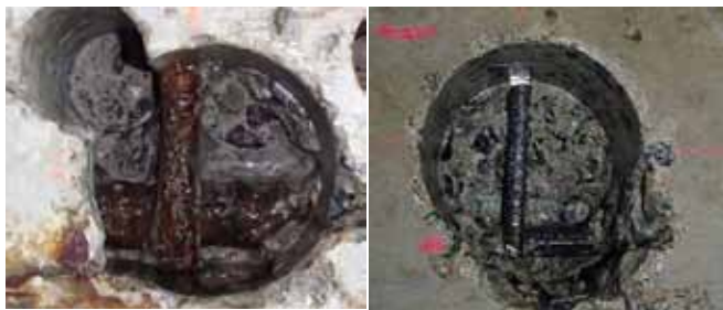
【コンクリートウェル部】
