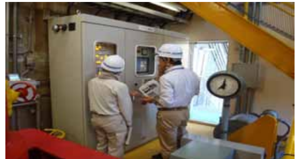
写真-6 ゲート機側操作盤での操作訓練
