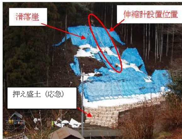
写真3.5 伸縮計の設置位置、滑落崖、押え盛土
