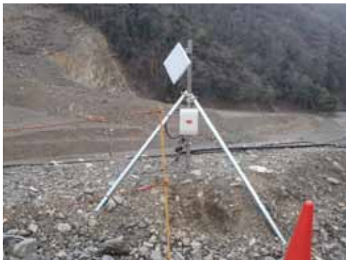
図-7 赤谷河道閉塞箇所設置状況
