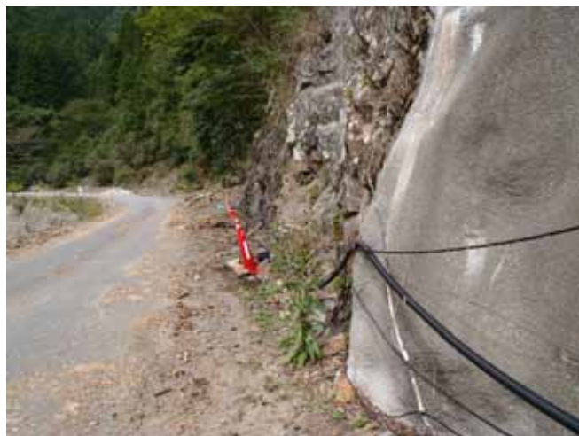
図－3 N T Tケーブル敷設状況
