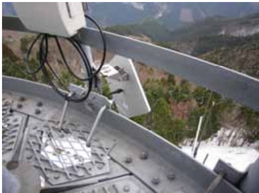
図-8 白六山無線中継所設置状況
