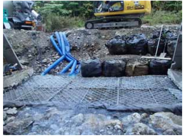
写真-8 基礎鋼製枠施工時の状況
