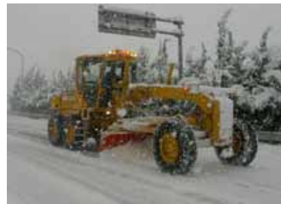
写真3-3 除雪状況(除雪グレーダ)
