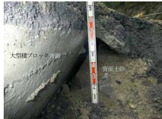
写真-5 大型積ブロック背面状況
