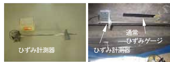
写真-3 計測器の設置状況
