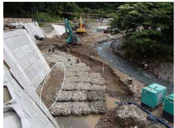
写真-7 根固工施工時の状況
