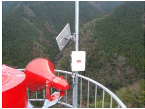
図-9 猿谷ダム管理支所設置状況
