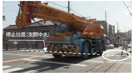
写真-2 静的載荷試験状況
