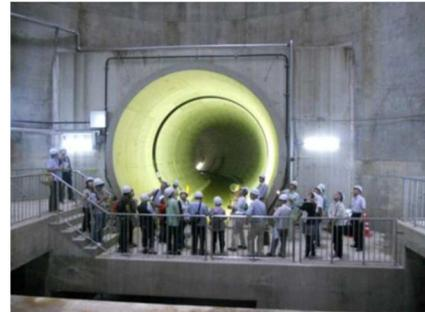
図-5 北幹線第 3 号管渠(内径 6.1m)
