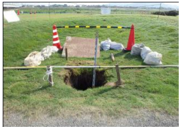
写真-1 高水敷における陥没
