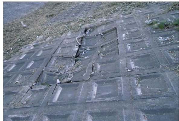
写真-2 護岸裏の空洞化
