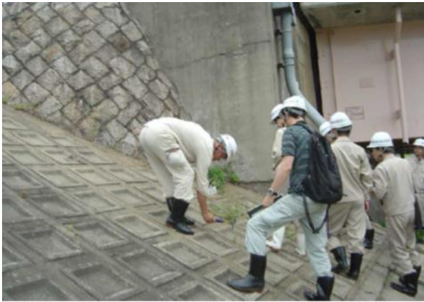
写真－3 点検実習の状況
