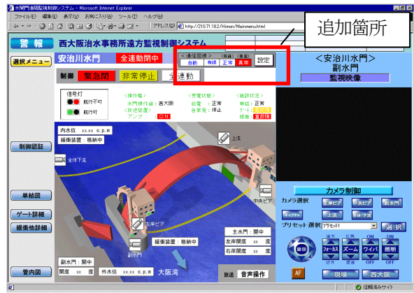
図11 整備後の遠隔操作画面
