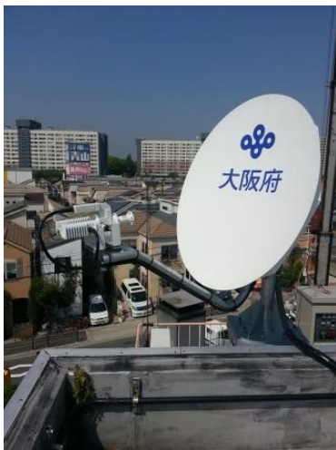
図9 アンテナ設置状況写真
