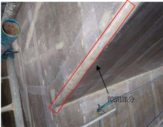
写真-5 ビニロン繊維シートを貼付けた状況
