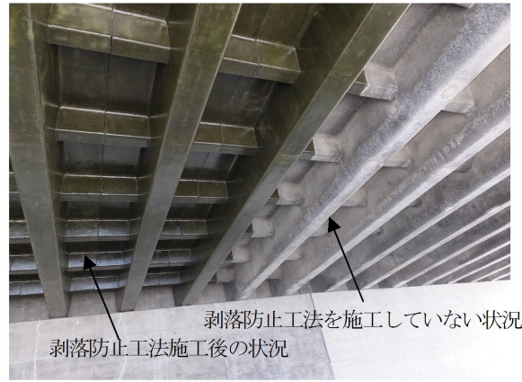
写真-7 樹脂を塗布する剥落防止工法施工後の状況
