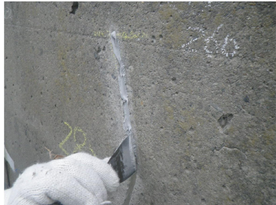
写真-3 充填工法の状況 (パテ仕上げ)
