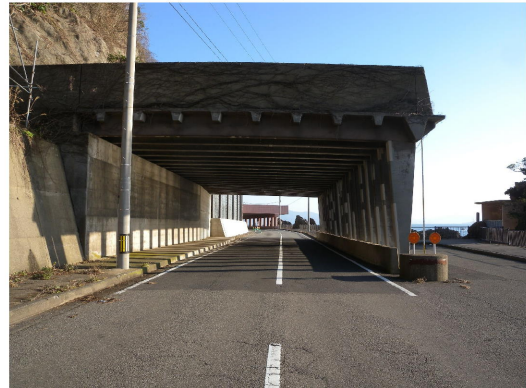
写真-1 午房ヶ平第一ロックシェット状況 (施工前)
