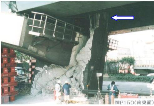
図-17 神P150崩壊状況(南東面)<sup>18)</sup>
