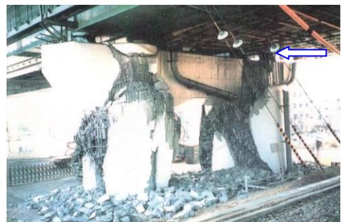
図-25 神P688門型柱の軸圧縮破壊(X型)<sup>20)</sup>
