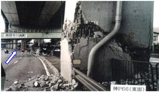
図-4(a) 神P66と西側の状況(西方の老番側を望む)<sup>18)</sup>
