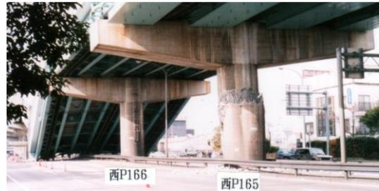
図-7 西P166(軽微)と西P165(圧縮破壊)の状況<sup>18)</sup>
