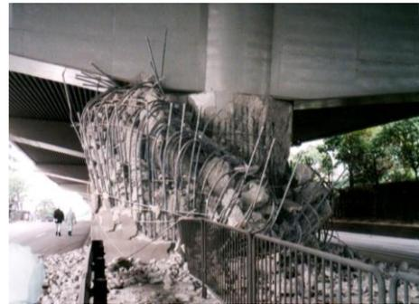
図-14 神P57柱の軸圧縮破壊(東面)<sup>18)</sup>
