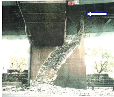
図-21 神P240崩壊状況(北面)<sup>20)</sup>
