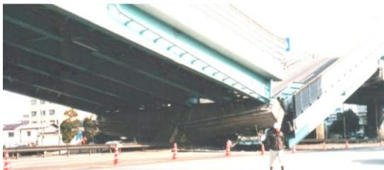
図-6 西P167の崩落状況<sup>18)</sup>
