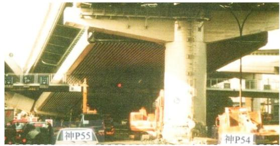
図-12 神P55(崩壊)と神P54(基部の曲げ損傷)<sup>20)</sup>
