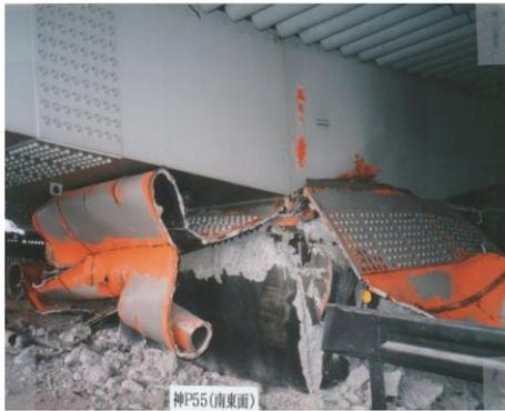
図-11 神P55柱の崩壊状況(南東面)<sup>18)</sup>
