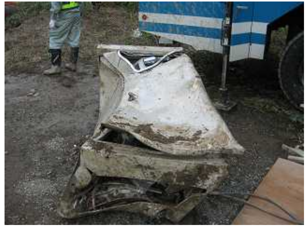
写真-6 トンネル照明制御盤の被災状況
