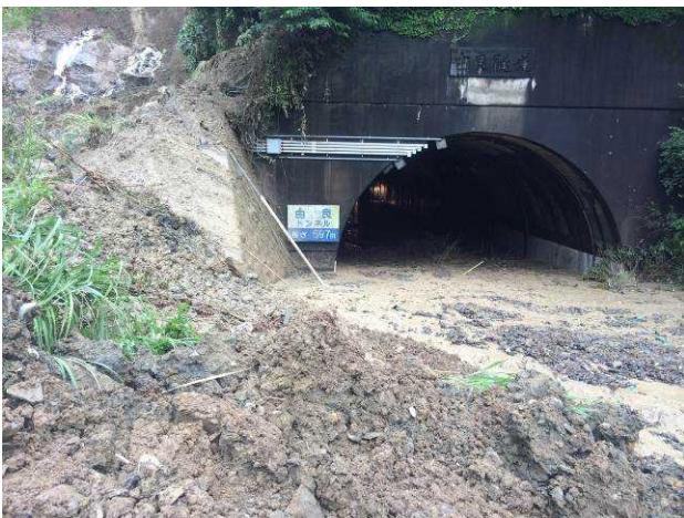
写真-5 トンネル北側坑口への崩落土砂流出状況
