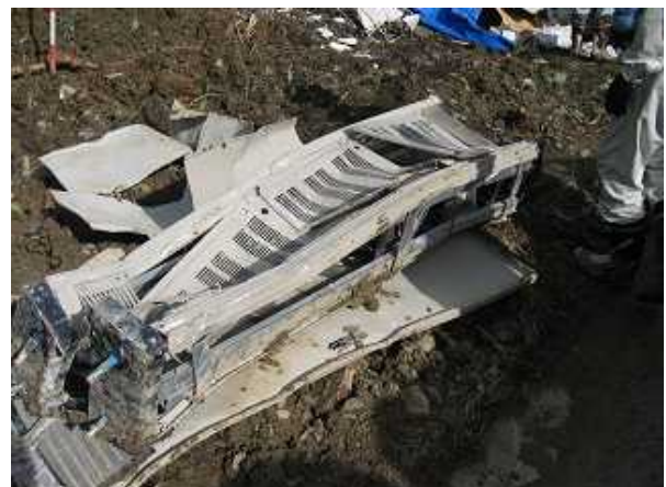
写真-8 トンネル内ラジオ再放送設備の被災状況
