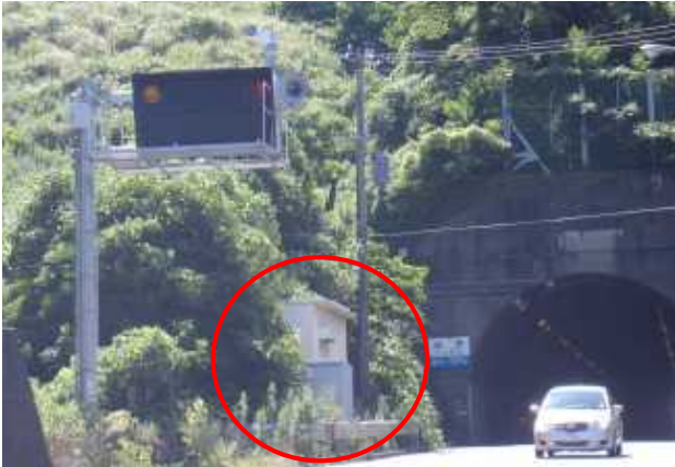
写真-4 トンネル付帯設備中樞の被災前の状況
