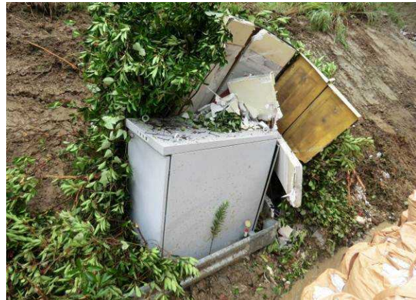
写真-7 トンネル非常警報設備（主制御装置）の被災状況
