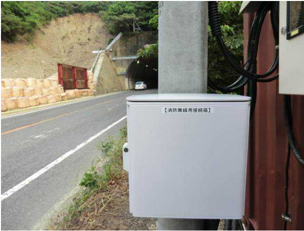
写真-11 ラジオ再放送設備（無線接続箱）の応急復旧状況
