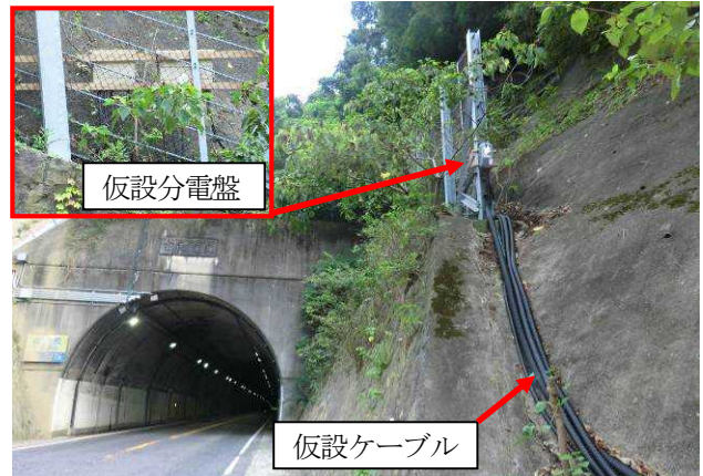
写真-9 トンネル照明設備の応急復旧状況
