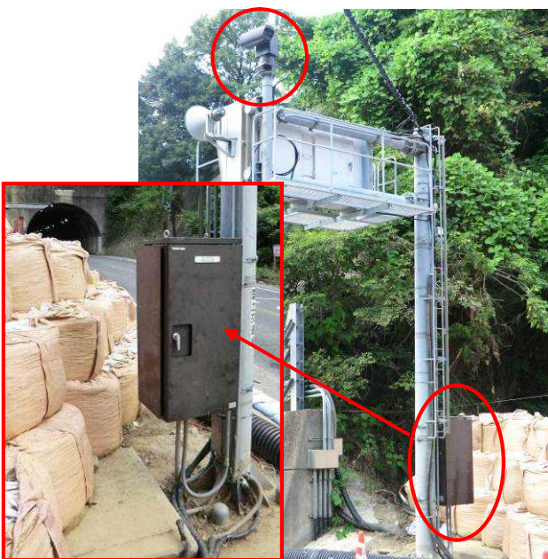
写真-12 CCTV設備の応急復旧状況
