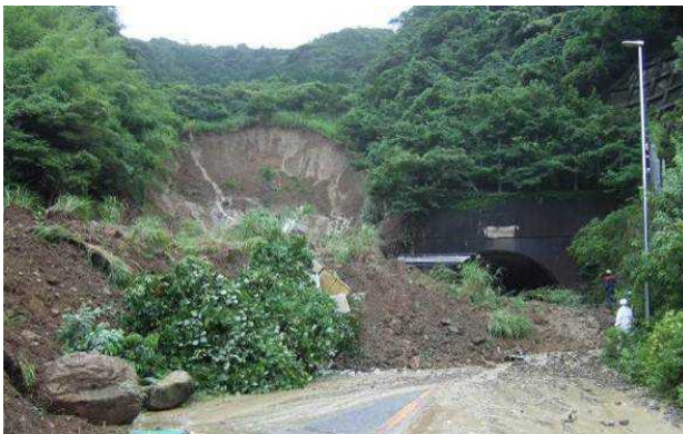
写真-3 国道42号 由良トンネル北側坑口付近
