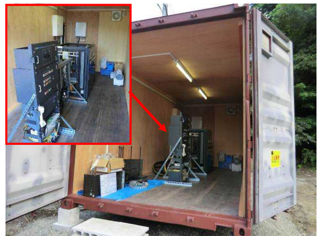
写真-10 トンネル非常警報設備の応急復旧状況
