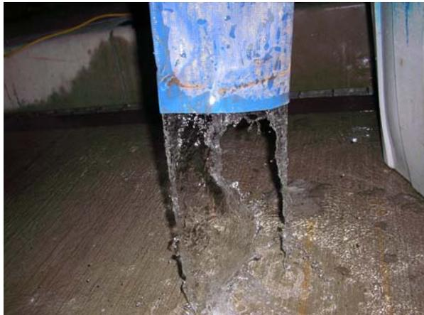
写真-5 集水ボーリング工排水状況
