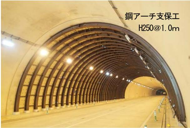
写真-3 鋼アーチ支保工設置状況
