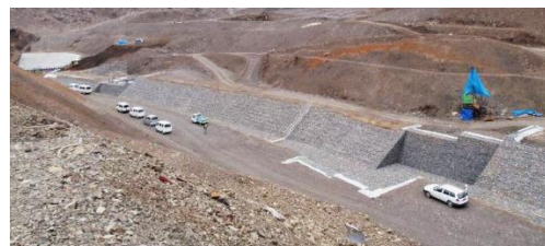
写真-3 仮排水路設置状況（2012年6月）
