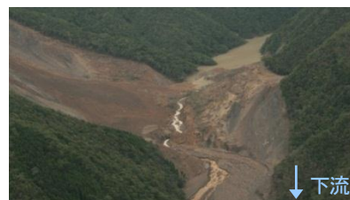
写真-4 台風15号による越流状況
