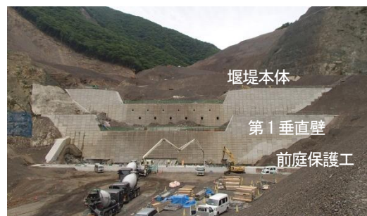
写真-9 堰堤箇所施工状況（2015年6月）
