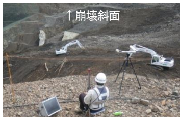
写真-7 無人化施工による土砂撤去作業
