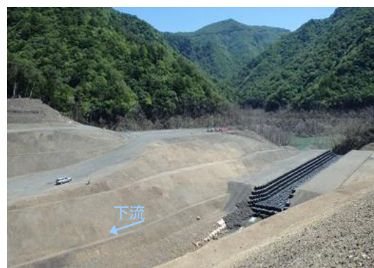
写真-16 河道閉塞上流部施工状況（2015年6月）
