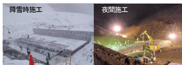
写真-2 仮排水路施工状況
