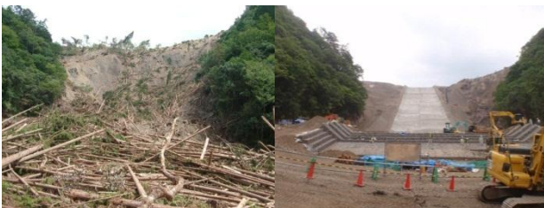
写真-11 仮排水路施工状況 (左: 施工前, 右: 施工中)
