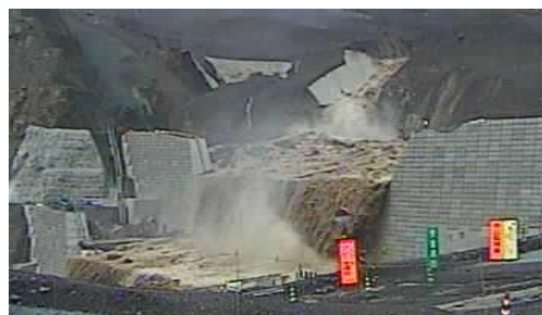
写真-8 砂防堰堤箇所出水状況
