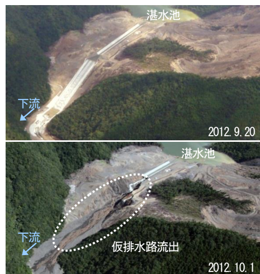
写真-12 仮排水路被災状況 (上: 被災前, 下: 被災後)
