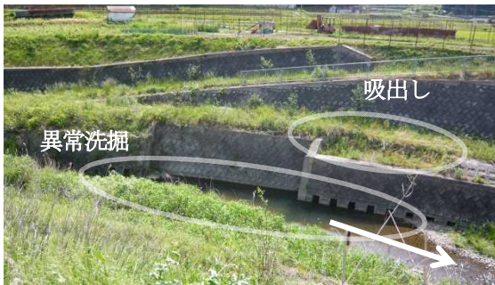
写真-5 石寄せ巣穴護岸の変状
