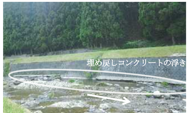
写真-1 河床低下の状況
