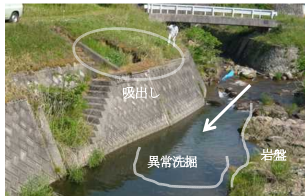
写真-2 異常洗掘と吸い出し
