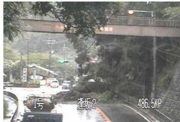
写真 国道1号大谷付近
