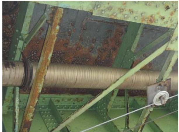
図-3 底鋼板の腐食状況
