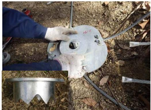
写真-4.3 押えパイプの取付け
