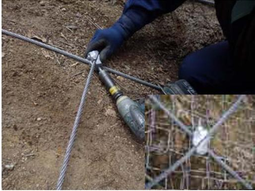
写真-4.4 SKクロスクリップ設置
