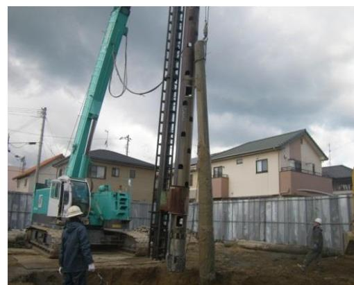
施工時品質の悪い既存杭を引抜く際には、引き倒し中に杭が折れる場合があります。これは、引抜杭を鉛直に吊っている場合は、クラック等が存在していてもRC棒鋼・PC鋼線によって繋がっていますが、引き倒しを開
