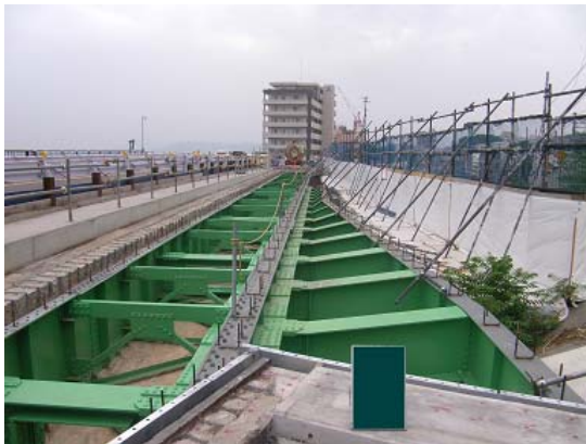
①設置前の状況
