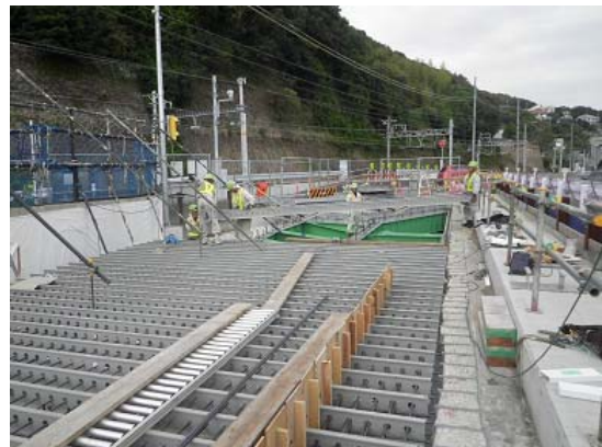
④パネルの架設
