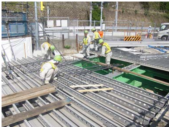
⑤下側鉄筋の配筋
