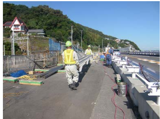
②パネルの運搬
