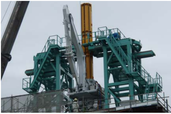
図-8 水中作業機昇降状況
