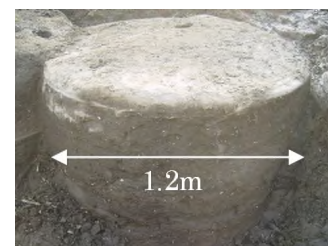
写真-4 改良体上部の状況
