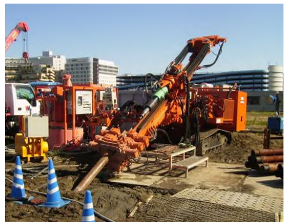
写真-3 斜め施工状況
