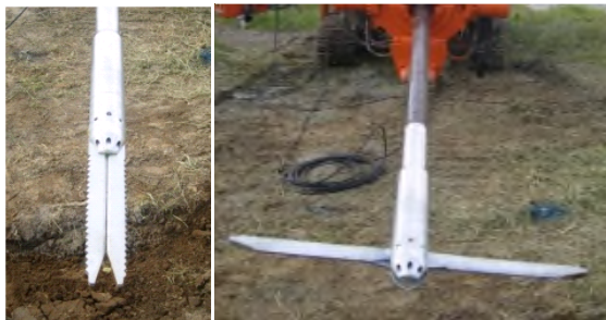
写真-1 攪拌翼開閉状況
