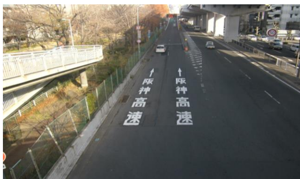
図-8 15号堺線堺入口付近（国道26号「安井町」交差点直後）
