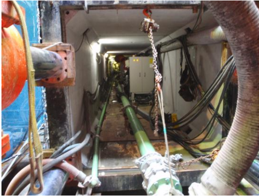
写真-4 坑内掘進時状況
