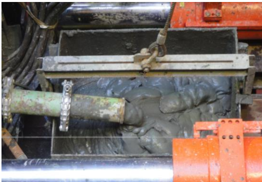
写真-5 立坑下排土状況
