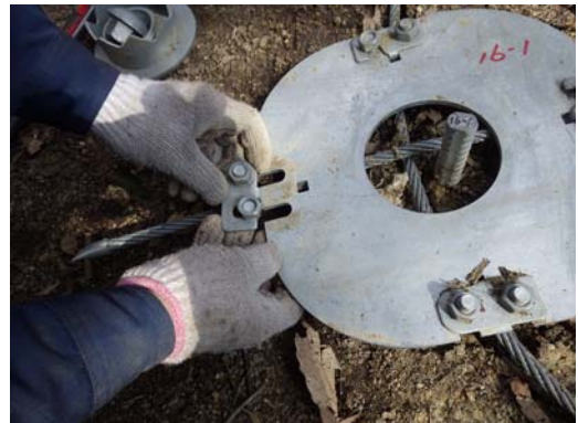
写真-4.2 ES-Uボルトの取付け
