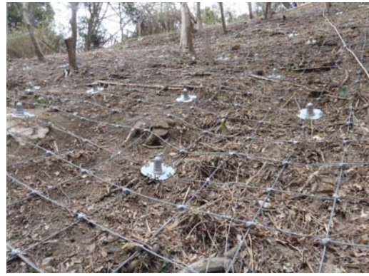
写真-5.2 施工直後
