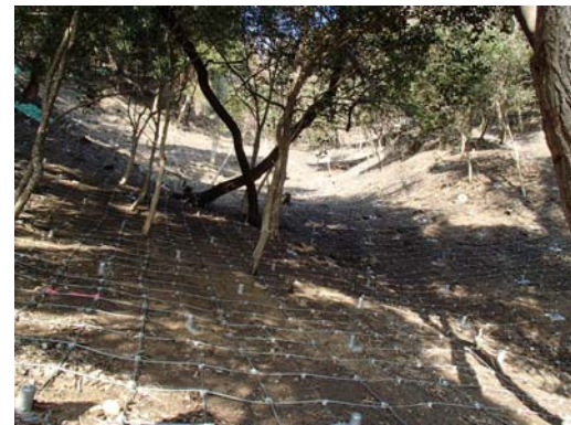
写真-5.3 施工直後
