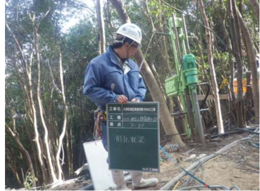
写真-4.1 削孔状況
