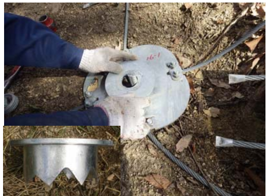
写真-4.3 押えパイプの取付け
