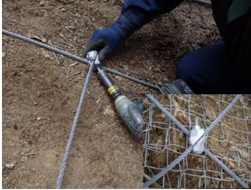
写真-4.4 SKクロスクリップ設置
