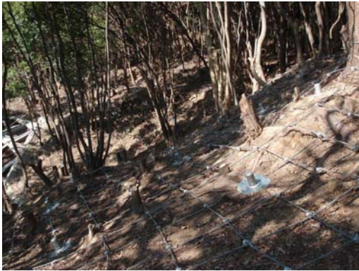
写真-4.5 施工完了
