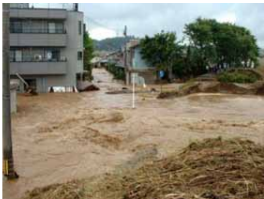
写真-1 足羽川決壊地点（福井市春日1丁目）
