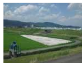
写真-2 小田遊水池周囲堤
